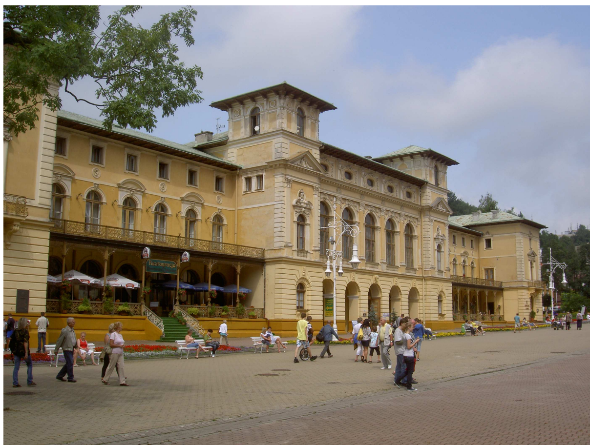
Fot. 8. Stary Dom Zdrojowy (1884 – 1889) arch. Julian Niedzielski, arch. Jan Zawiejski, fot. autorki.
