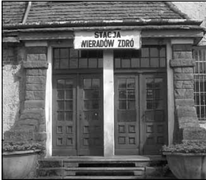
Stacja PKP Świeradów Zdrój. Fot. Celina Cnota.
